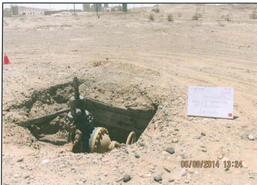
Fotografía N° 2. Pozo abandonado con válvula de ajuste y parte de la estructura de madera al parecer ha sido pintado recientemente.
