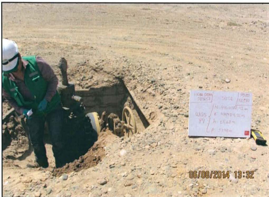
Fotografía N° 3. Primer punto de muestreo a 1,1 m del pozo dentro del hoyo.
