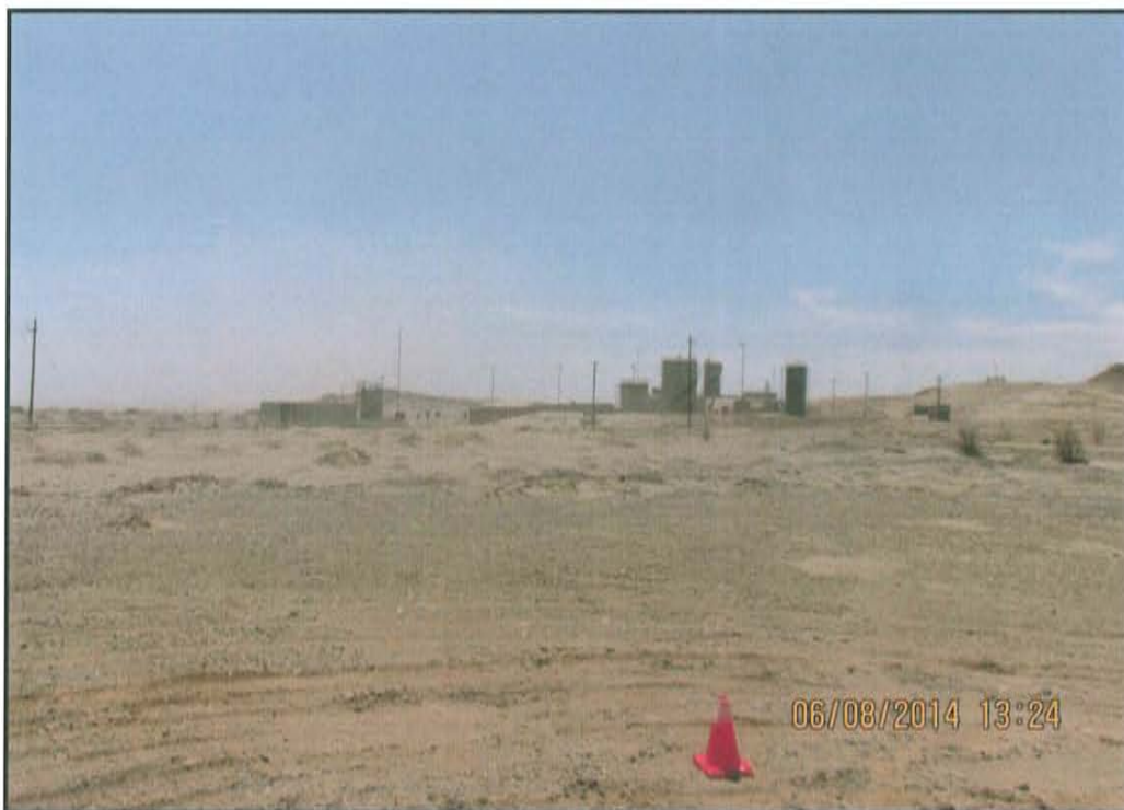
Fotografía N° 1. Vista panorámica de la zona adyacente del pozo con ficha OEFA F01657 y código PERUPETRO T2570, se observa la llanura desértica con parte de la estructura del actual operador del lote.
