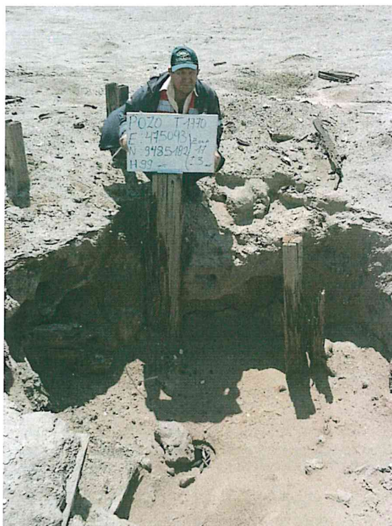
Fotografía N° 1. Pozo inactivo con código PERUPETRO T1770 donde se observa el casing dentro de un hoyo (posible restos de cantina de madera).
