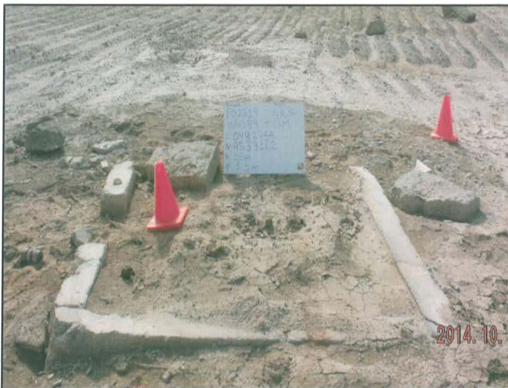
Fotografía N° 1. Zona en evaluación del pozo A9636, con casing ni cabezal visibles, sólo se aprecia cantina deteriorada.
