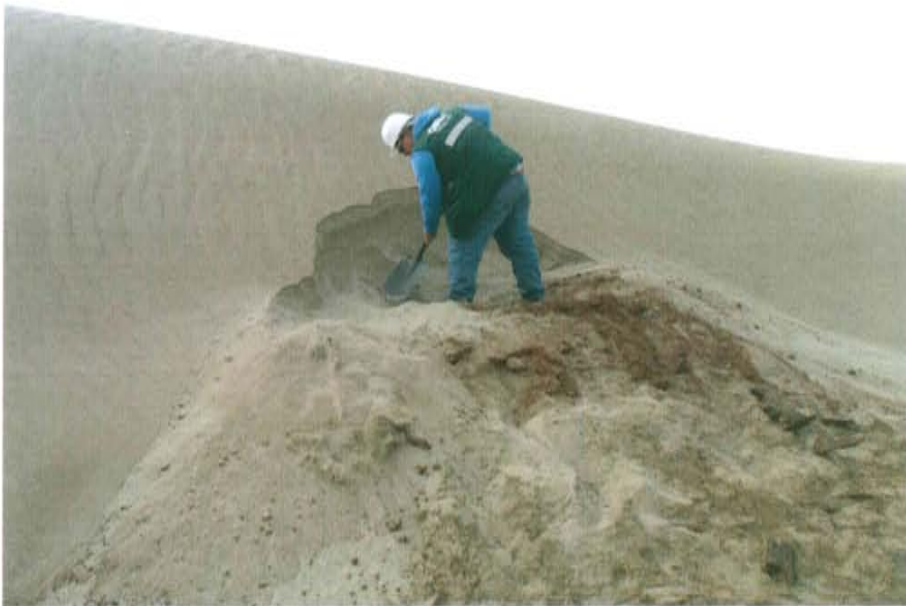
Fotografía N° 2. Se realizan trabajos de excavación y se observa debajo de la duna monticular suelos impregnados con hidrocarburos también restos de metal y madera.
