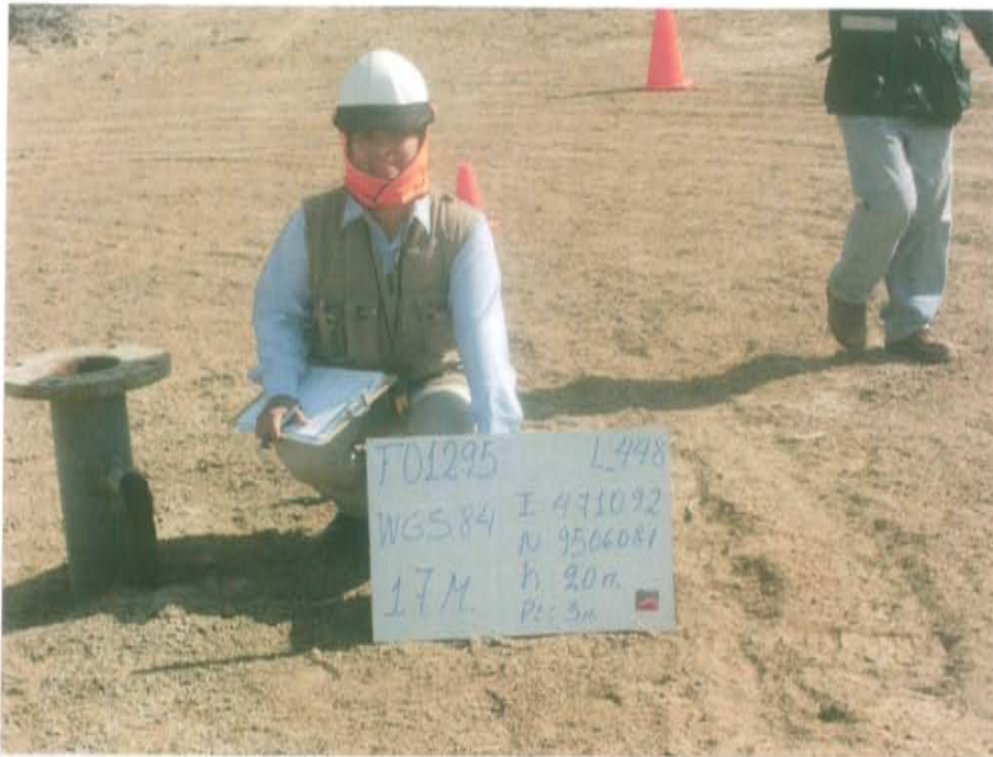
Fotografía N° 1. Pozo L_448 presenta cabezal con brida y tubería de desfogue abiertos sin elementos de cierre que garanticen su hermetismo.
