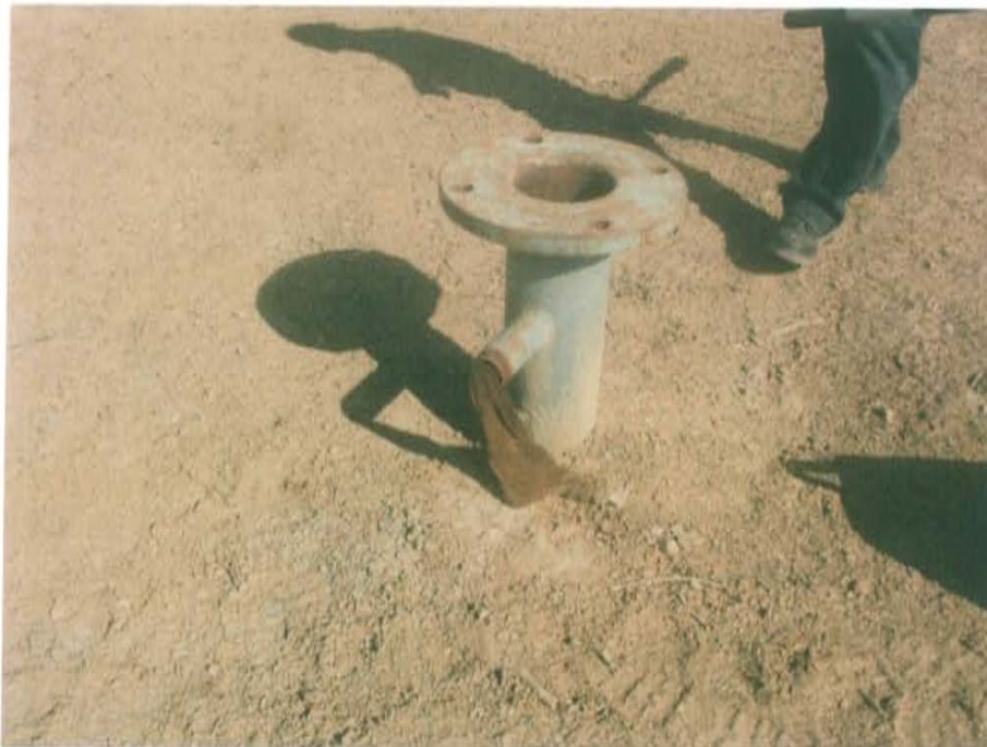
Fotografía N° 2. Pozo L_448 sin emisiones gaseosas ni afloramientos sobre un terraplén reconformado.
