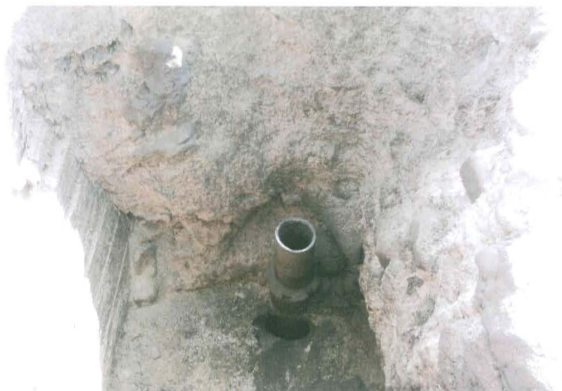
Fotografía N° 01.- Pozo con código PERUPETRO T2663 con Ficha OEFA F01237, se observa el casing con una tubería, corroídos sin cabezal y/o algún accesorio de cierre por lo que se encuentra abierto al ambiente.
