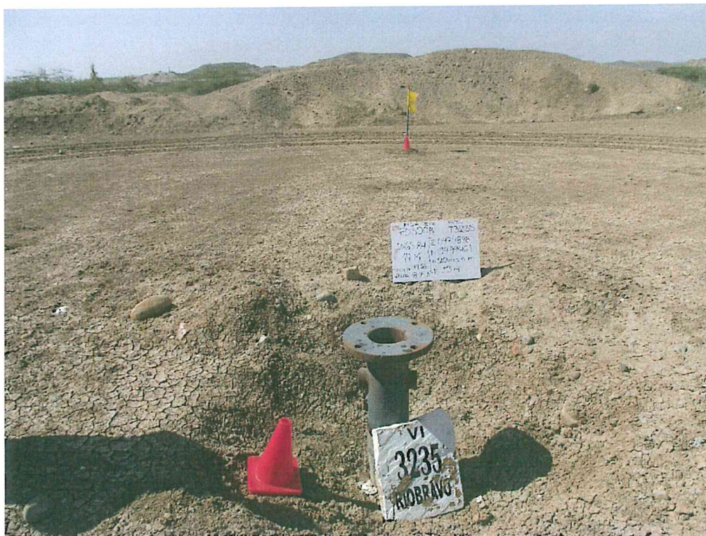
Fotografía N° 1. Ubicación del pozo inactivo T3235 dentro de una pequeña excavación. Se observó un casing ligeramente corroído, sin cabezal y unido a la mitad inferior de una brida de 12 pulgadas de diámetro, el casing presenta 2 tuberías laterales sin válvulas que aseguren su hermetismo.
