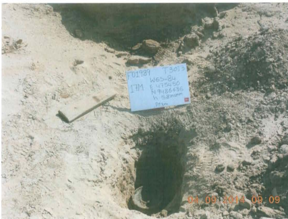
Fotografía N° 1. Pozo con código PETRUPETRO T3013 inactivo mal abandonado que se encuentra abierto al ambiente
