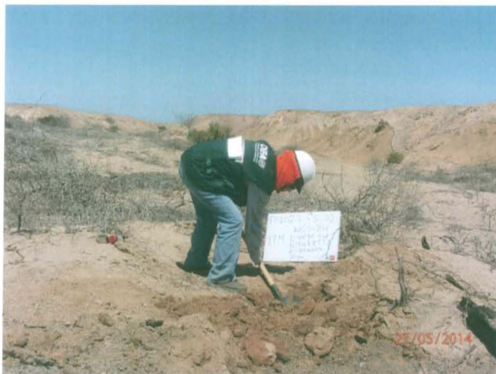
Fotografía N° 2. Vista panorámica de la posible ubicación de pozo.
