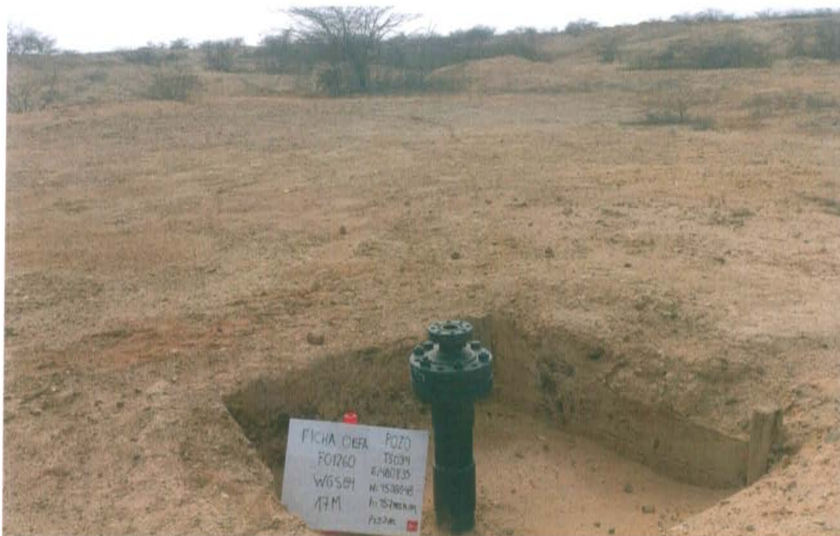
Fotografía N° 2. Vista panorámica del pozo T5034, se observa un terreno no habilitado tipo terraplén que presenta una cantina de sección cuadrada; asimismo, escasa vegetación sobre una superficie accidentada.
