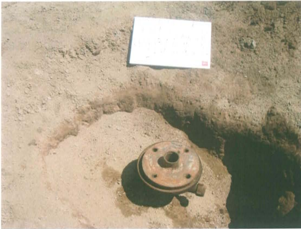
Fotografía N° 1. Identificación del pozo inactivo con código PERUPETRO L_548. Presenta casing con brida abierto al medio ambiente.
