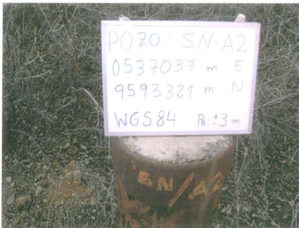
Fotografía N° 1. Pozo abandonado perteneciente a la Ficha OEFA F00740, con cemento en el interior y casing deteriorado.
