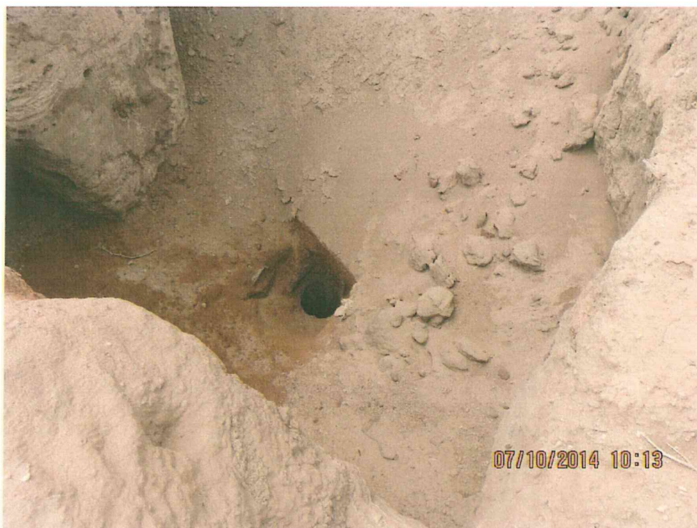
Fotografía N° 1. Vista pozo T2257, se observa el casing corroído y abierto al ambiente.
