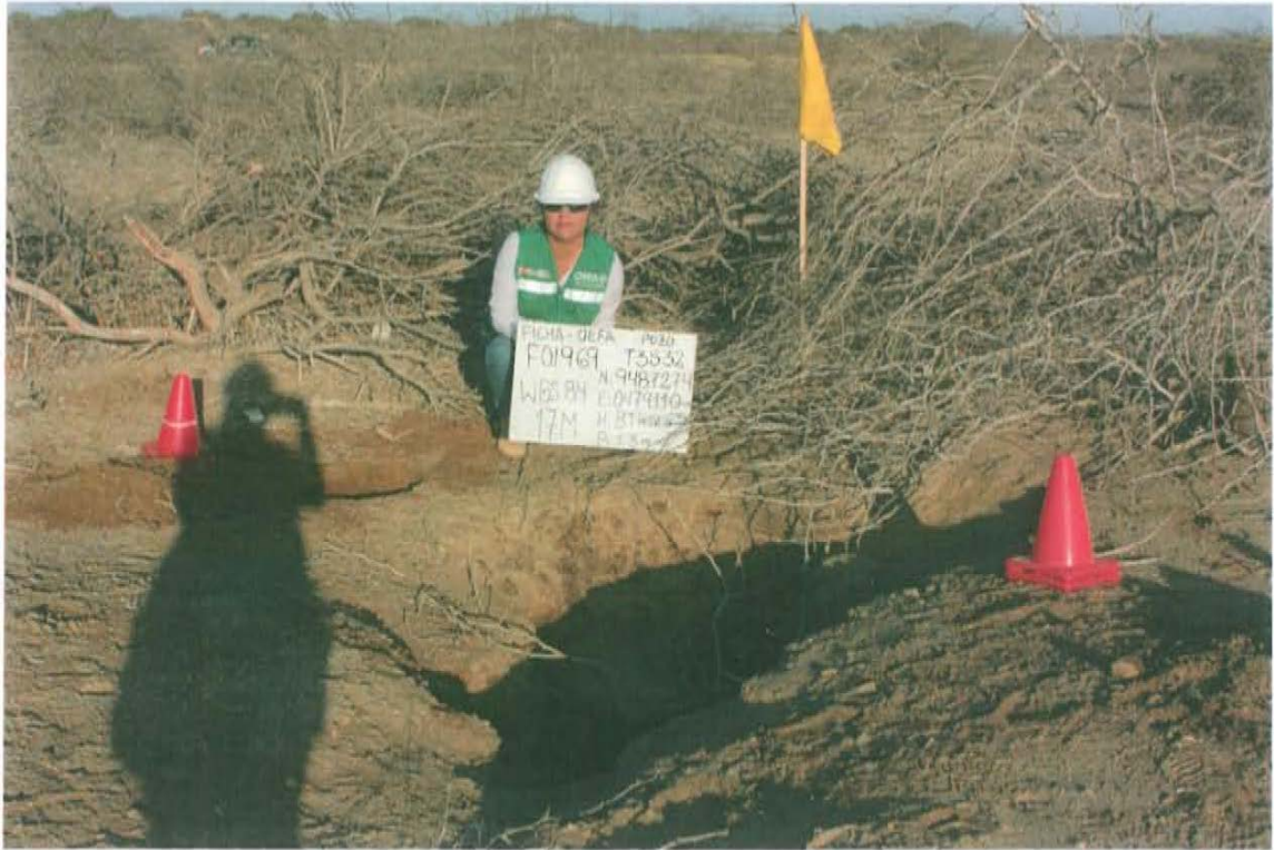
Fotografía N° 1. Pozo inactivo con código PERUPETRO T3532 el cual se encontró en la base de un hoyo, posiblemente cantina deteriorada.
