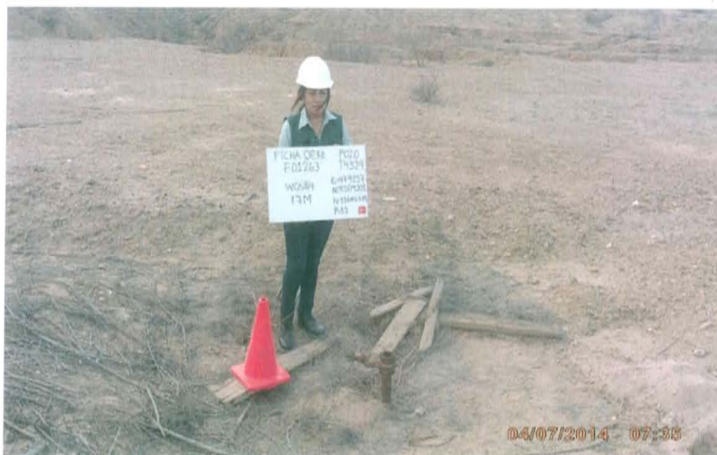
Fotografía N° 2. Vista del pozo, el casing que sobresale 0,40 m de la superficie del suelo.
