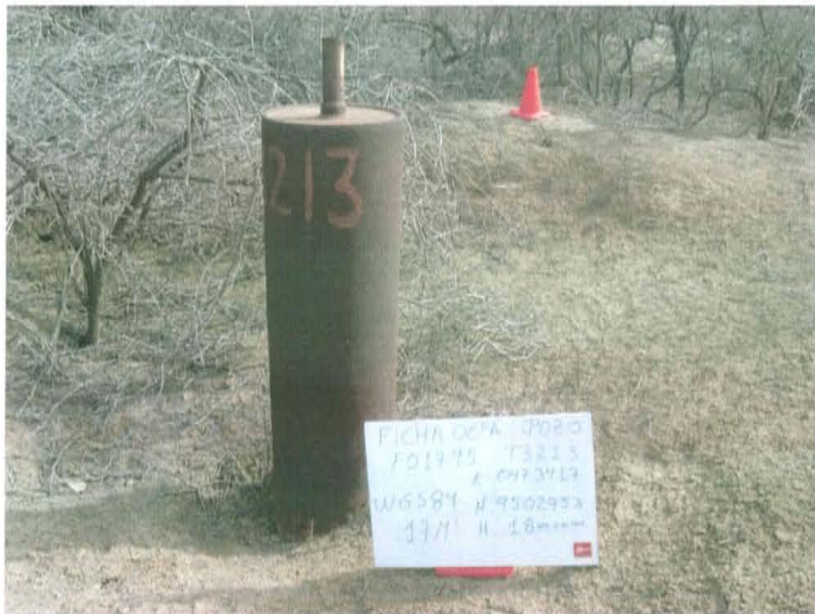
Fotografía N° 1. Pozo inactivo, con casing cementado y presenta un tubo extensor en la parte superior.
