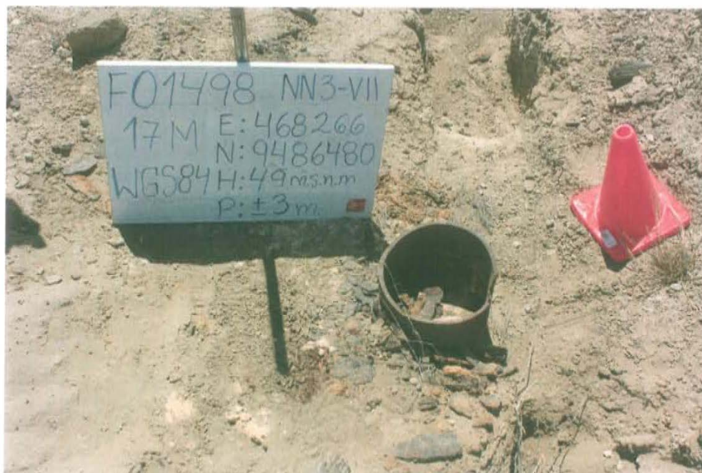
Fotografía N° 1. Pozo inactivo, presenta casing cortado y corroído.
