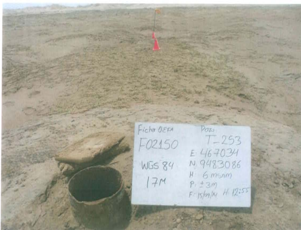
Fotografía N° 1. Se observa casing de aproximadamente 9,5 plg de diámetro que se encuentra abierto al ambiente.
