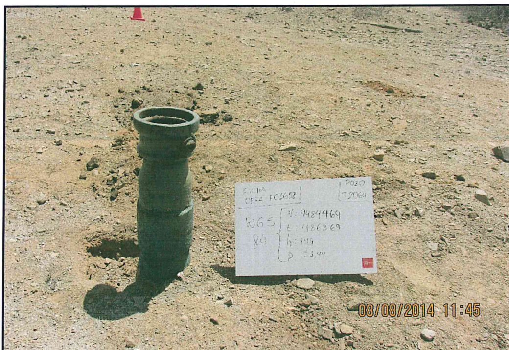
Fotografía N° 2. Casing del pozo T2064 de 12 plg de diametro el cual emerge 0,7 m de la superficie del suelo.
