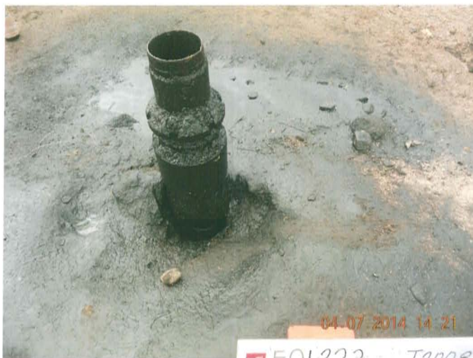
Fotografía N° 2. Se observa casing que sobresale 0,87 m desde el nivel del suelo, donde se aprecia suelo con presencia de hidrocarburos líquidos.
