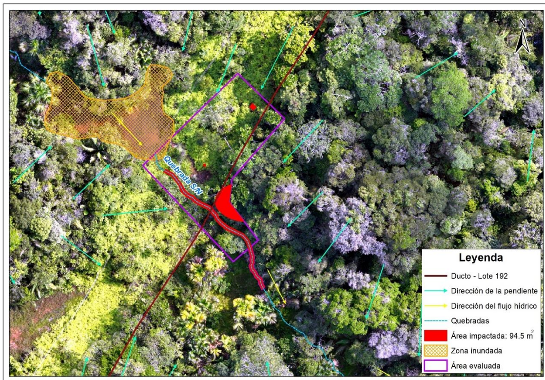
Figura 9.2. Área impactada del sitio S0242
