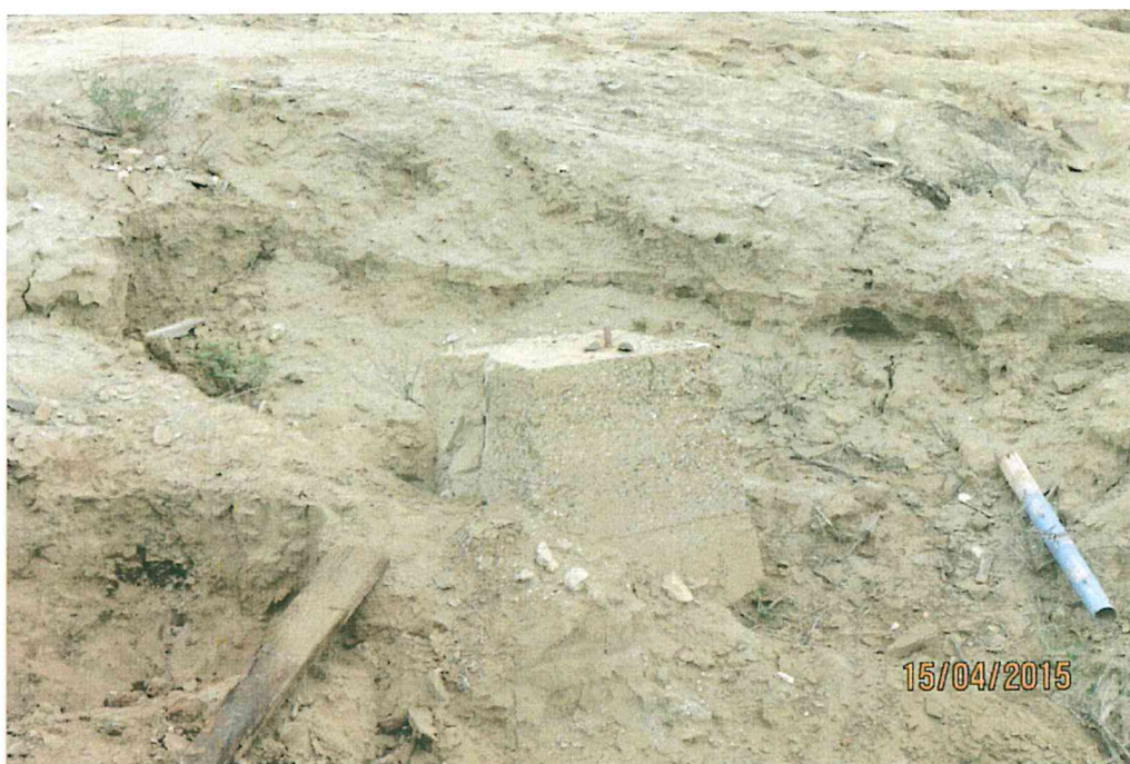
Fotografía N° 1. Se observa indicios de la existencia del pozo como boques o base de concreto utilizados en esta actividad de hidrocarburos.
