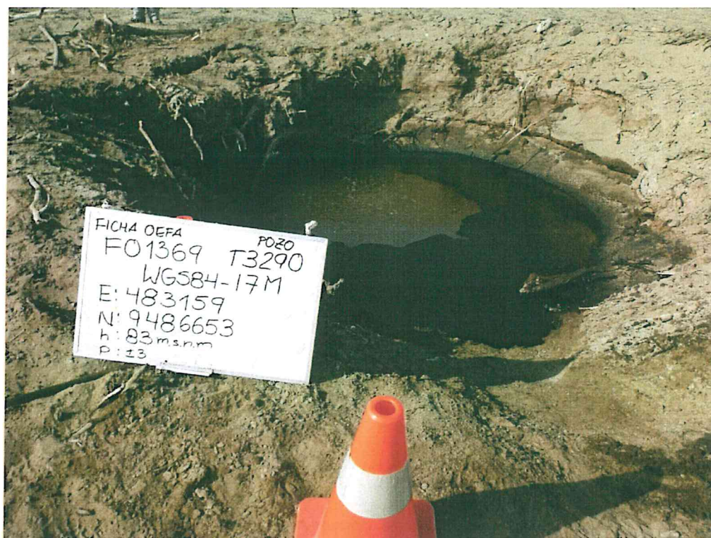
Fotografía N° 1. Identificación del pozo inactivo con código PERUPETRO T3290. Presenta excavación con fluidos que burbujean, en cuyo interior se encontraría el casing.
