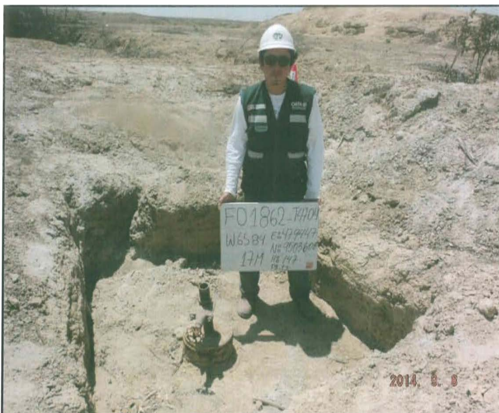
Fotografía N° 1. Pozo inactivo con cabezal enterrado, presenta brida y válvula concéntrica, dentro de hoyo.
