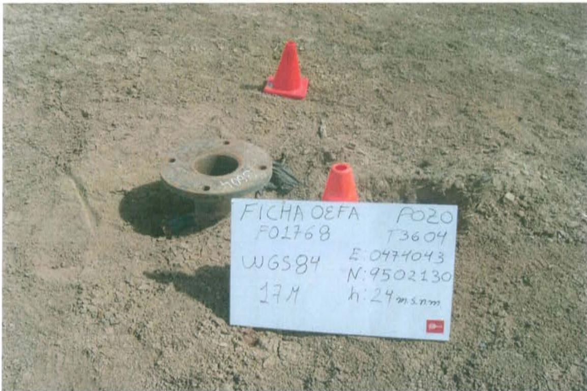
Fotografía N° 01.- Pozo con código PERUPETRO T3604 y código Ficha OEFA F01768, se observa el casing corroído con una tubería lateral unido a una brida sin cabezal o válvula que asegure su hermetismo por lo que se encuentra expuesto al ambiente.
