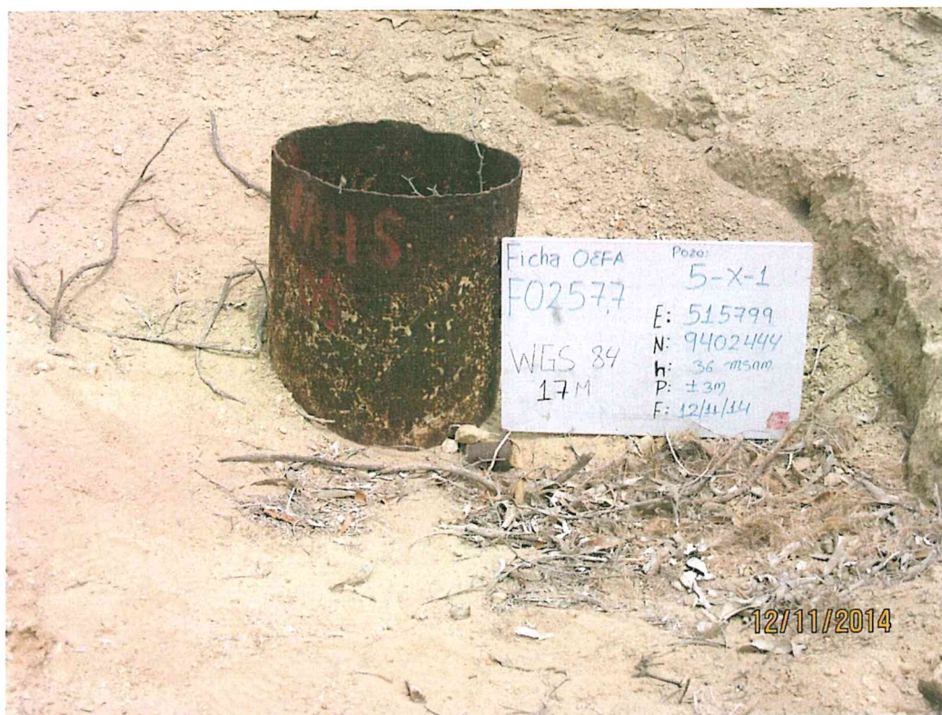
Fotografía N° 1. Se observa casing corroído de aproximadamente 20 plg de diámetro que se encuentra abierto al ambiente.
