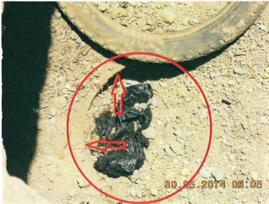
Fotografía N° 3. Se observa casing abierto de aproximadamente 20 plg de diámetro, sin accesorios que aseguren su hermetismo, cubierto al ras de arena y grava.
