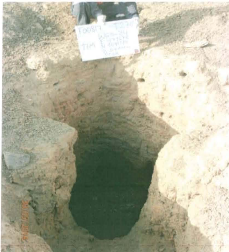
Fotografía N° 2. Vista de un hoyo de 5,1 m 2 y 3m de profundidad, en el cual está ubicado el casing cubierto al ras de arena y grava.
