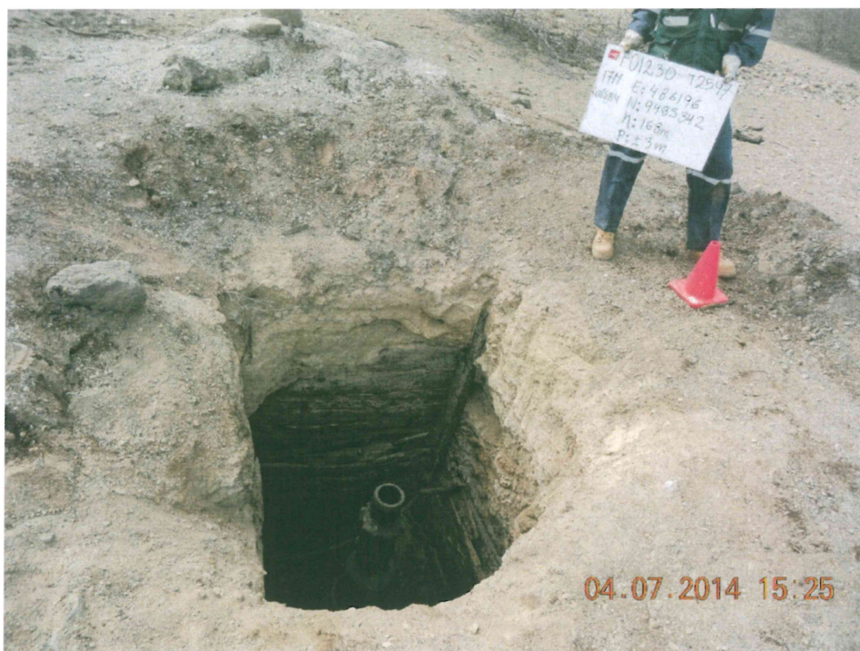
Fotografía N° 2. Coordenadas de ubicación del pozo abierto al ambiente, con casing y cabezal corroídos presentan hidrocarburos en su superficie, ubicados en el interior de un hoyo de 1,8 m x 1,4 m x 2,3 m de profundidad.
