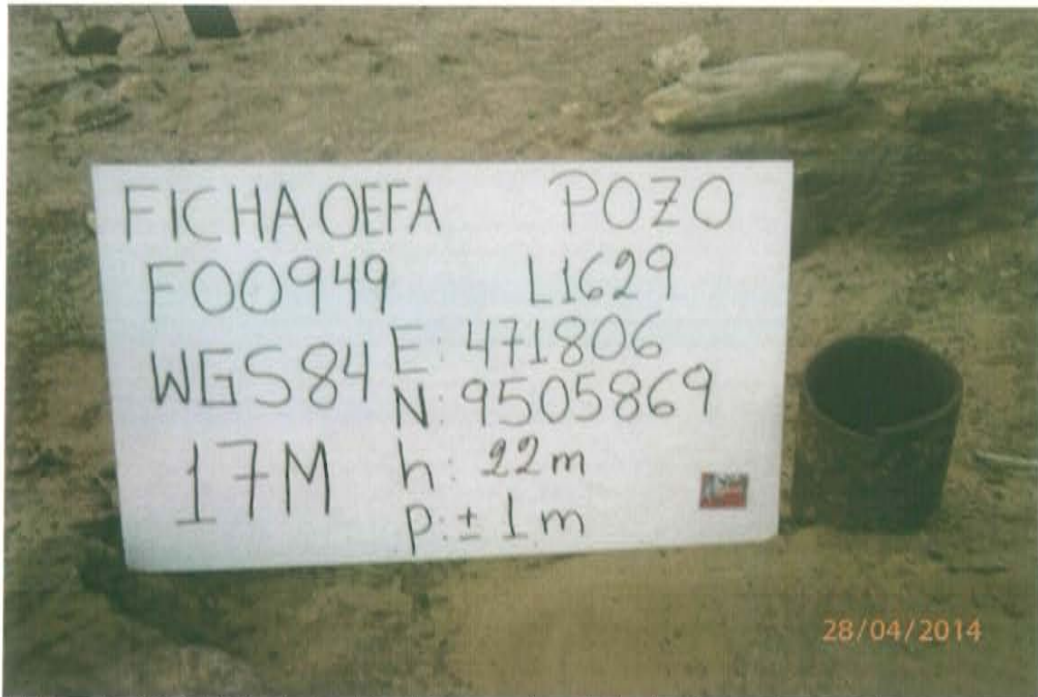
Fotografía N° 1. Vista de la ubicación georeferenciado donde se observa el pozo con el casing abierto al medio ambiente en estado de deterioro .
