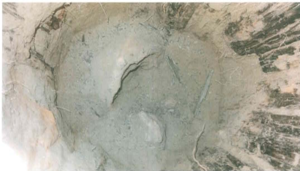
Fotografía N° 2. Luego de una excavación se encontró casing con tapa de fierro en estado corroído, en un hoyo revestido de madera.
