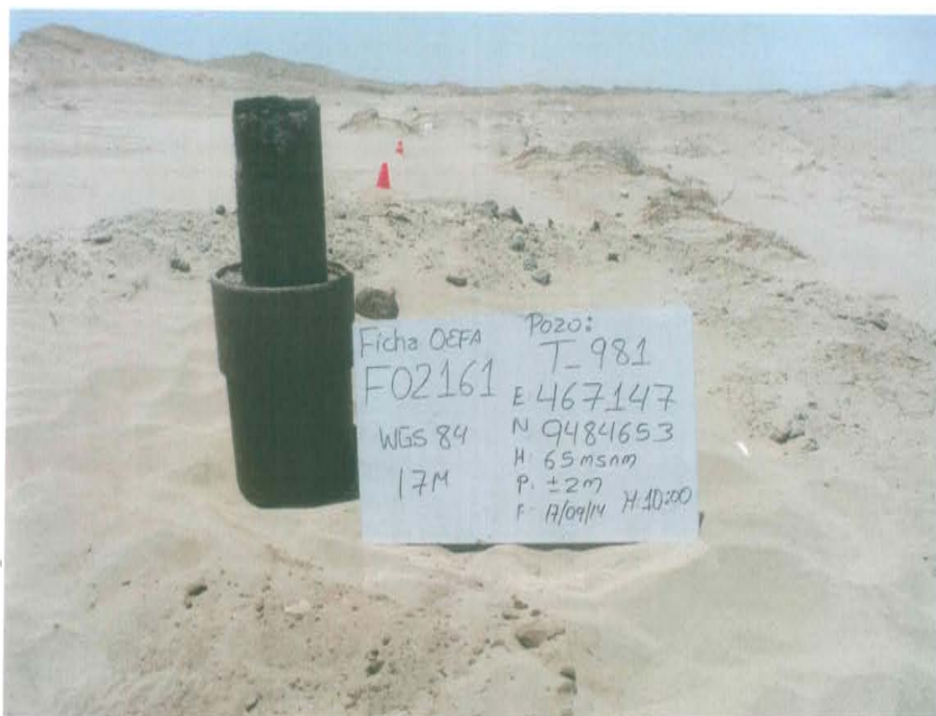
Fotografía N° 1. Se observa dos (02) casing concéntricos corroídos.
