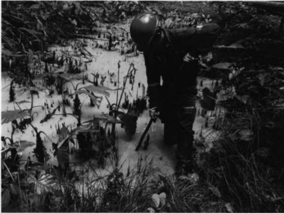
Fotografía 1. Hincado en zona baja y anegada al sur del sitio.
