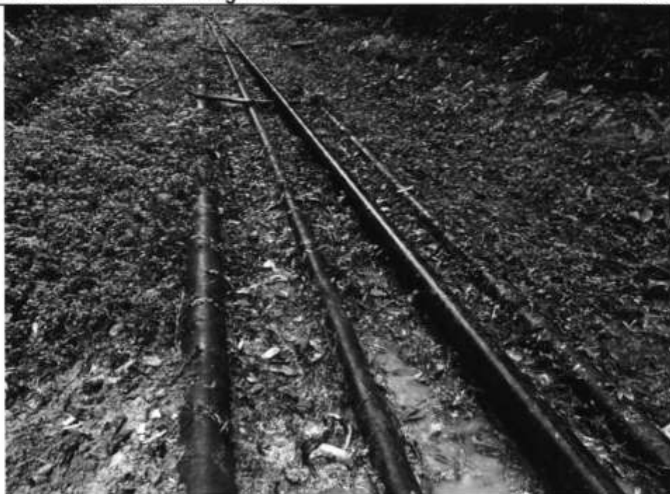
Fotografía 3. Sistema de ducto activo atravesando el sitio.
