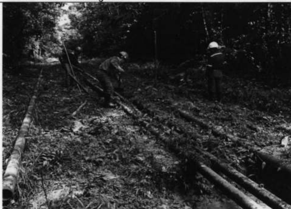
Fotografía 5. Trabajos de mantenimiento del ducto cerca del sitio.
