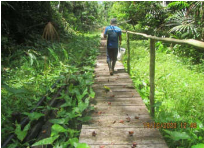
Vista panorámica de los ductos y el derecho de vía que atraviesan el sitio S0443
