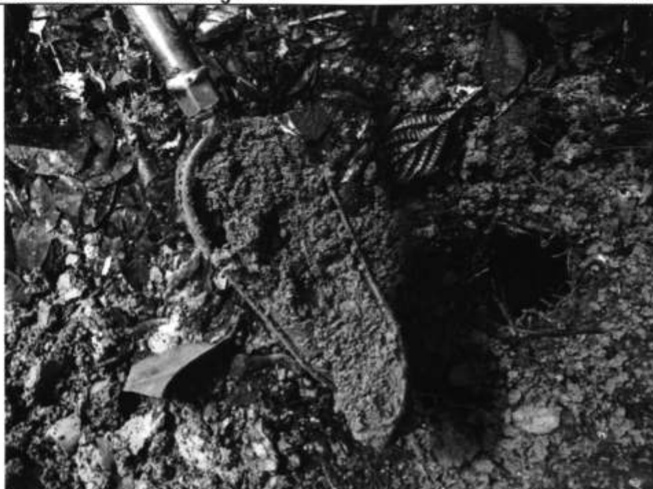
Fotografía 7. Presencia de suelo arcillo limoso en sondeos.
