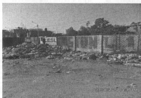
Punto crítico, Prolongación Grau en el distrito de Parcona, Junio - 2012
