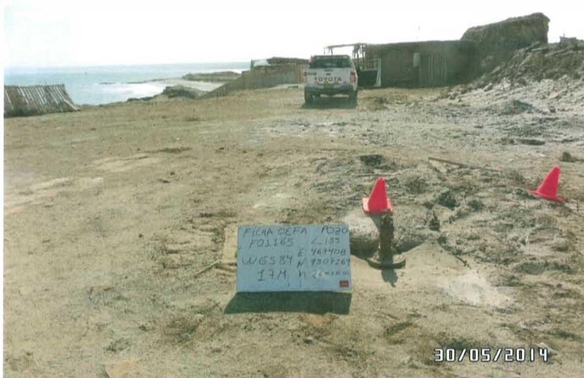
Fotografía N° 02.- Vista panorámica del pozo L_155, se observa una superficie habilitada nivelada muy próxima a viviendas y al mar.
