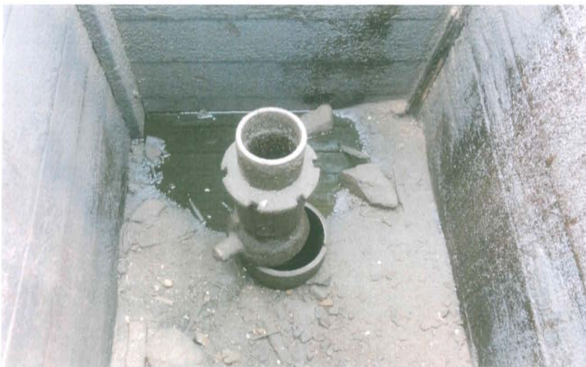
Fotografía N° 01.- Pozo con código PERUPETRO T2350 con Ficha OEFA F01233, se observa el casing con un cabezal que no presenta ningún accesorio de cierre por lo que se encuentra abierto al ambiente.
