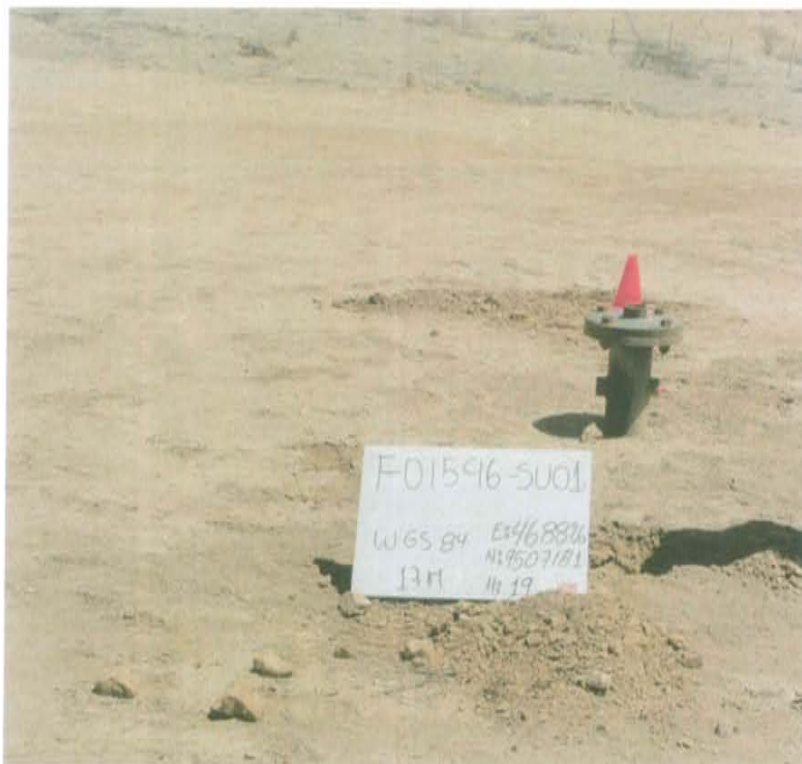
Fotografía N° 1. Pozo inactivo con código PERUPETRO L_134, en terreno habilitado tipo terraplén con acceso vehicular directo. El cabezal del pozo sobresale 0,35 m sobre nivel del suelo.
