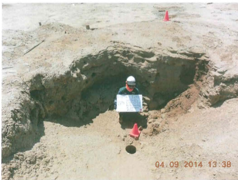
Fotografía N° 2. Vista de la ubicación del pozo T2921 abierto y expuesto al ambiente sin accesorios que aseguren su hermetismo, en el interior de un hoyo de 2,1 m de profundidad, donde se observa un casing de 10 plg.
