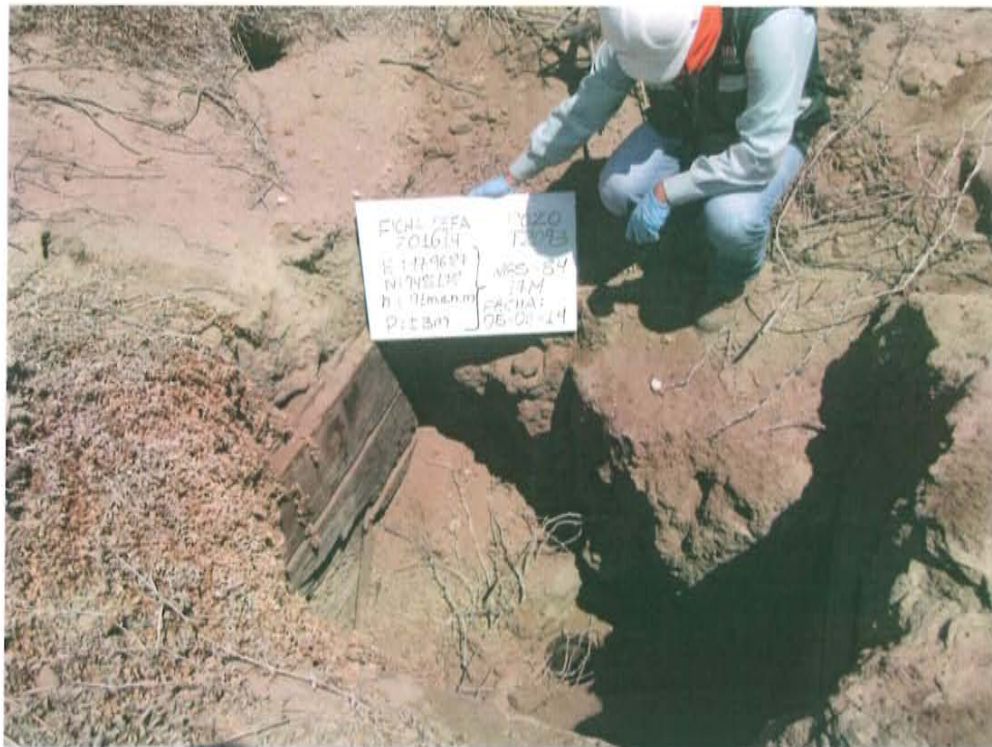
Fotografía N° 1. El Pozo T2093, presenta casing al ras del suelo, de aproximadamente 8 pulgadas y se encuentra dentro de un hoyo de sección cuadrada rodeada de madera en las paredes.
