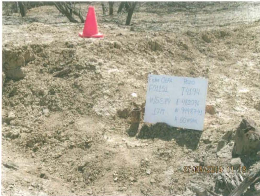
Fotografía N° 1. Pozo inactivo con código PERUPETRO T4194 enterrado, presenta tubo sobre el nivel del suelo de 2 pulgadas, dentro de un hoyo en terreno no habilitado.
