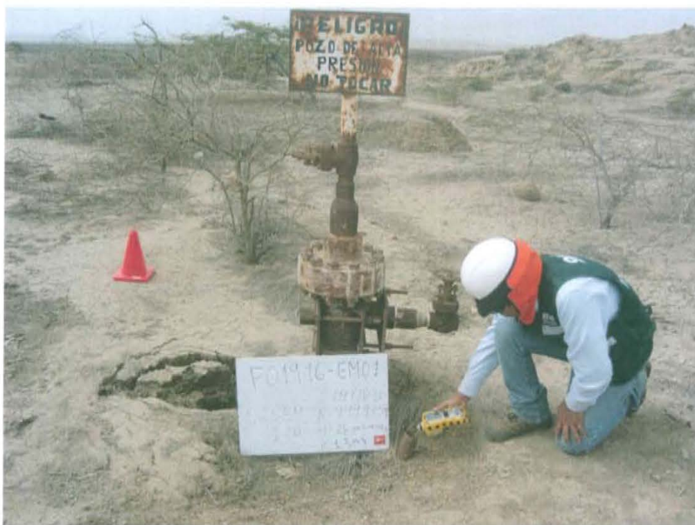
Fotografía N° 5. Medición en el punto F01916-EM01, ubicado en la fuente de emisión en boca del pozo T4010.
