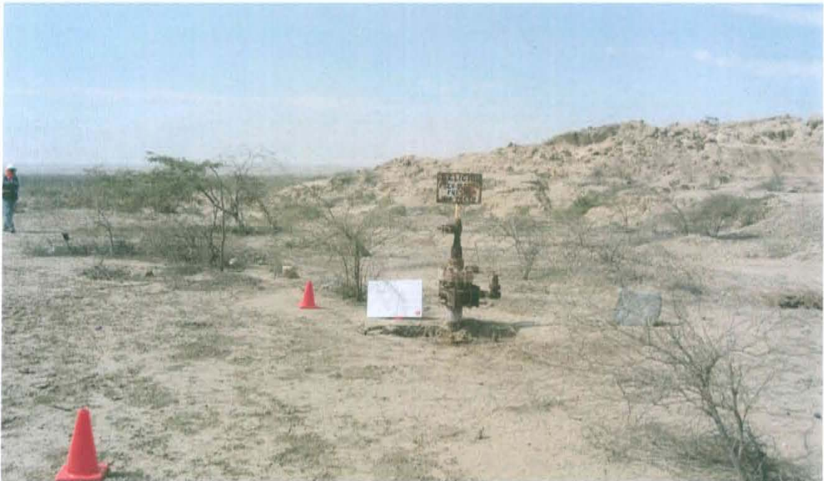
Fotografía N° 2. Vista panorámica del pozo T4010, se observa un terreno con acceso vehicular directo con vegetación a sus alrededores.
