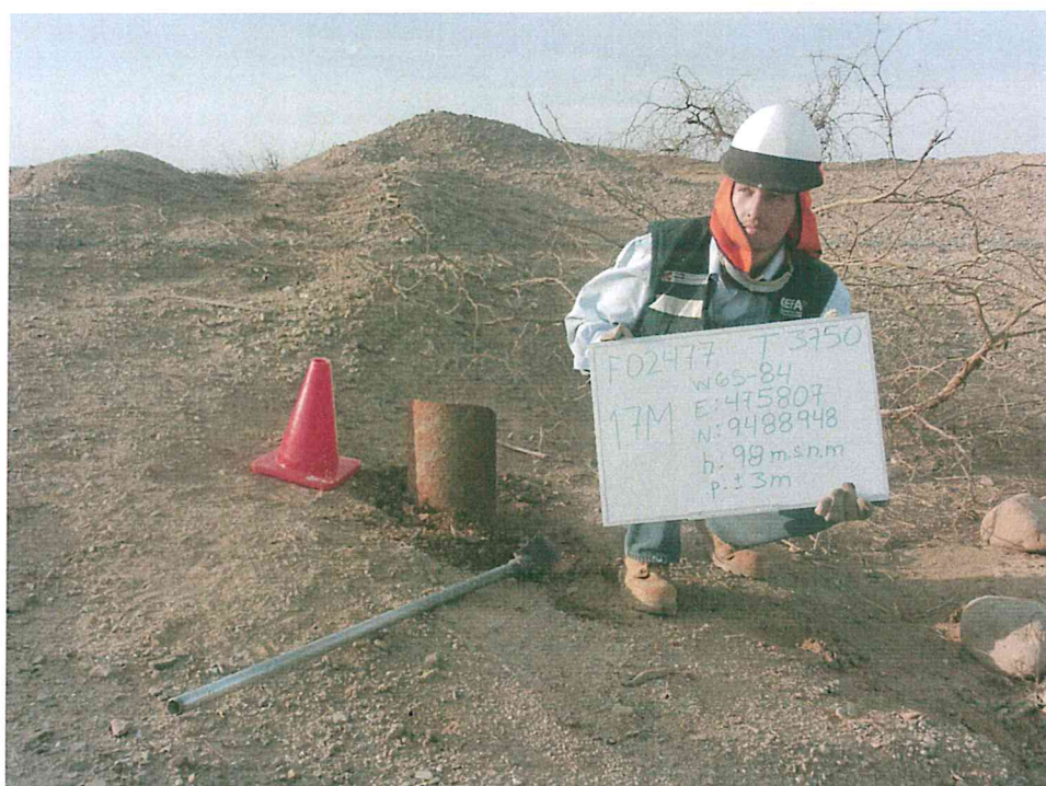
Fotografía N° 2. Se observa un pozo abierto y expuesto al ambiente sin accesorios que aseguren su hermetismo.
