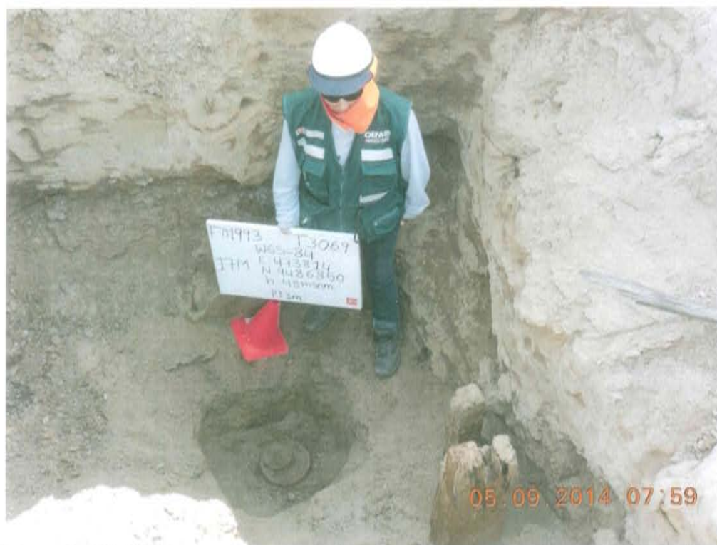
Fotografía N° 1. Pozo inactivo con casing corroído se encuentra dentro de un hoyo.
