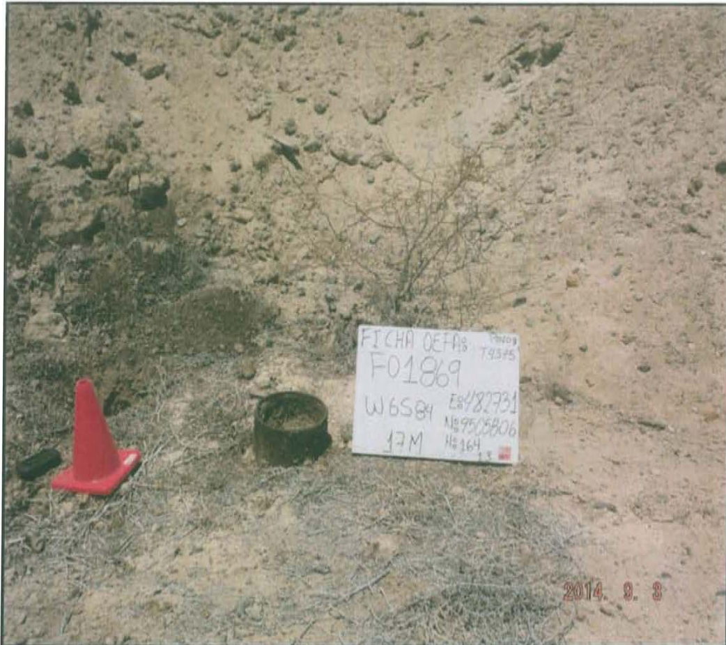
Fotografía N° 1. Pozo inactivo, se visualiza casing que sobresale 0,2 m desde la superficie del suelo.
