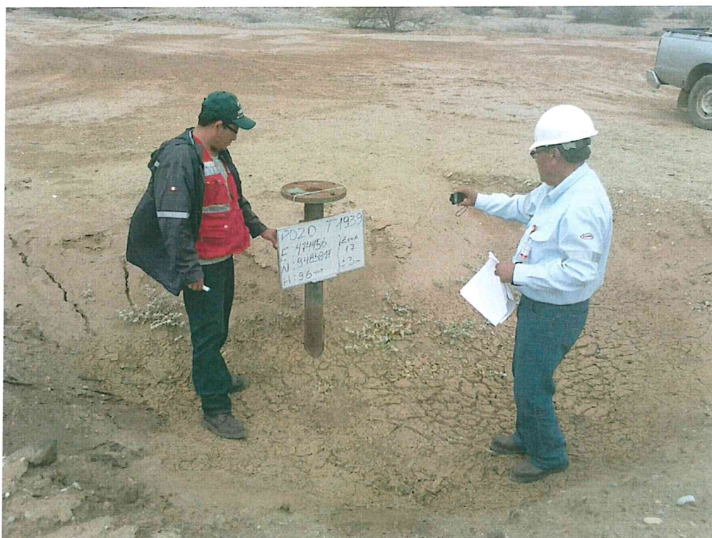
Fotografía N° 1. Pozo inactivo con código PERUPETRO T1939 que presenta casing con una parte correspondiente a la brida.
