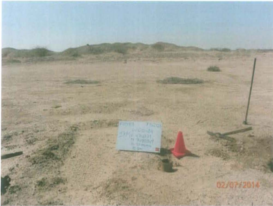
Fotografía N°1. Pozo inactivo abierto, sin cabezal ni válvula que aseguren su hermetismo, por lo que se encuentra expuesto al ambiente.
