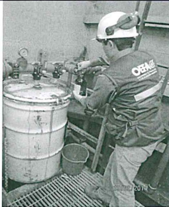
Fotografía N° 3. Llave de control instalada en la tubería de vertimiento, después del tratamiento, de donde se tomó las muestras de agua.
