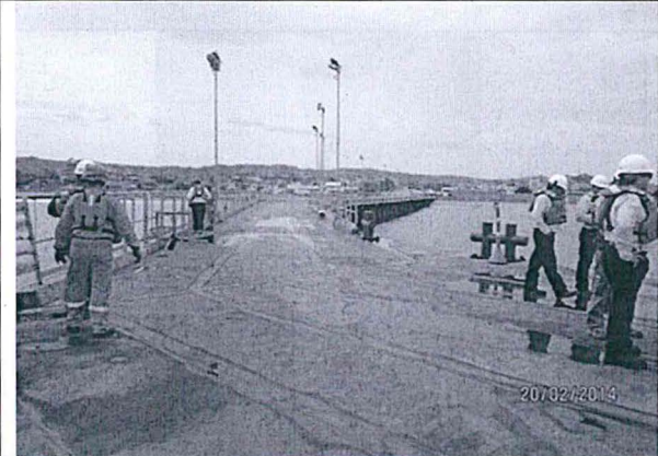
Fotografía N° 1. Muelle La Cruz, utilizado para estiba y desestiba de material utilizada en las plataformas del Lote Z-1.
