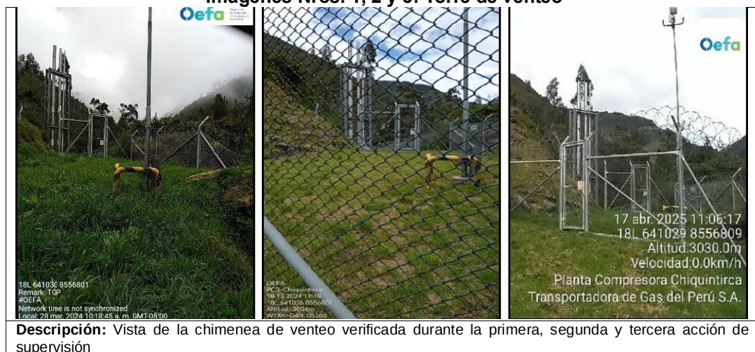
Imágenes Nros. 1, 2 y 3: Torre de venteo
