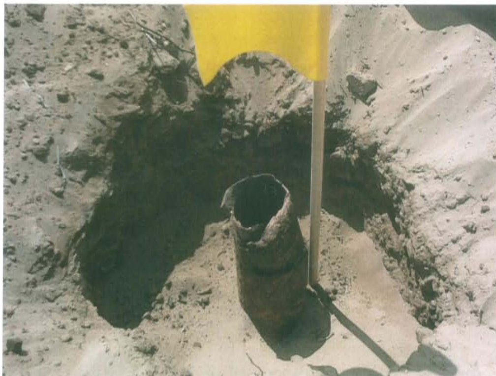
Fotografía N° 1. Identificación del pozo inactivo con código PERUPETRO L__73. Presenta casing sin elementos de cierre en la superficie.
