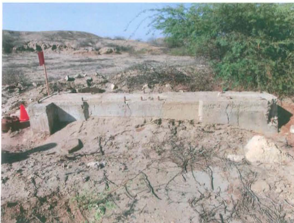
Fotografía N° 2. Adyacente al Pozo T2629, se observa una base de concreto (soporte de equipo de extracción mecánica de petróleo crudo).
