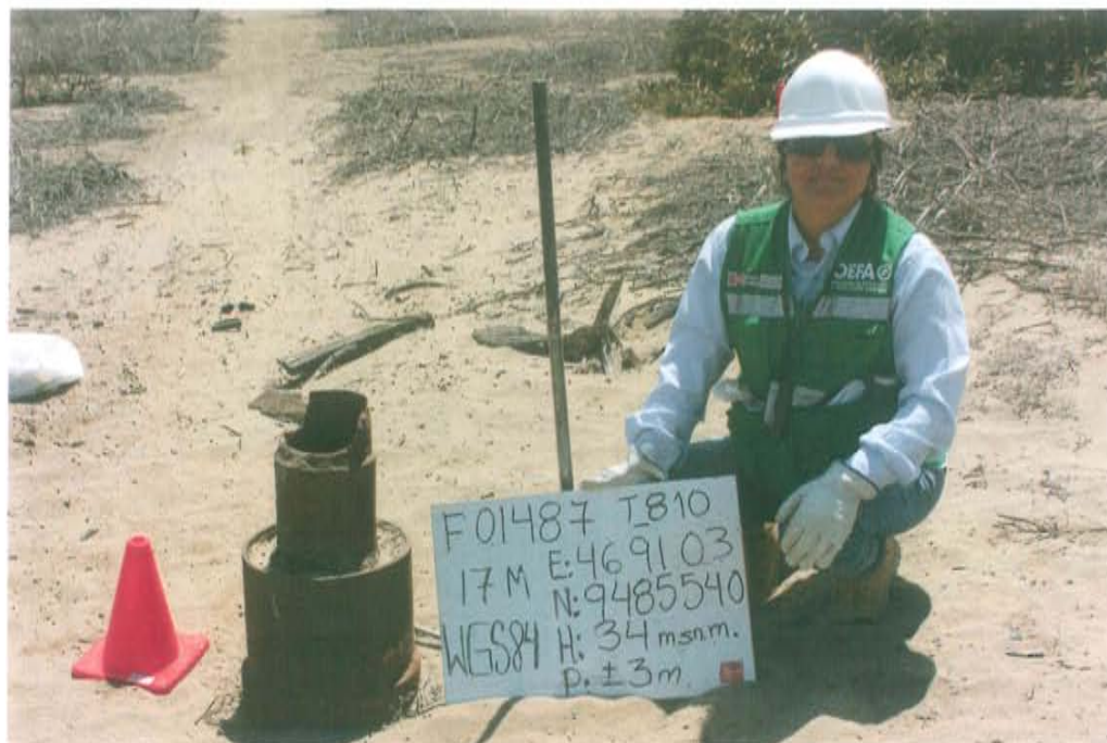
Fotografía N° 1. Pozo T_810, presenta casing de superficie y casing de producción abierto al ambiente.
